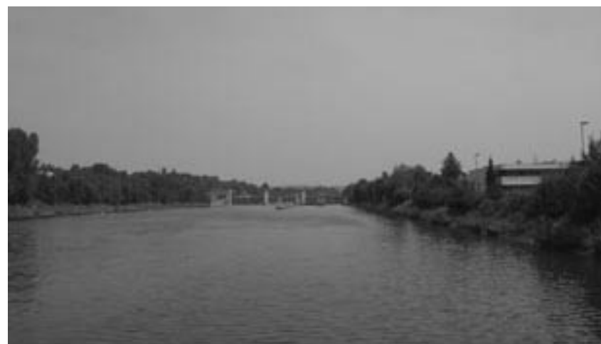
SCHIFFFAHRTSSTRAßE NECKAR BEI ALDINGEN MIT DÄMMEN LINKS UND RECHTS SOWIE SCHLEUSE IM HINTERGRUND FOTO: KARL BURGMAIER
