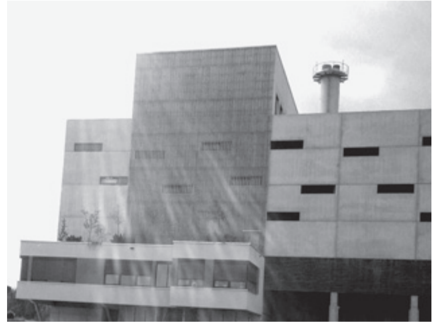
Das neue Holzheizkraftwerk Ludwigsburg
