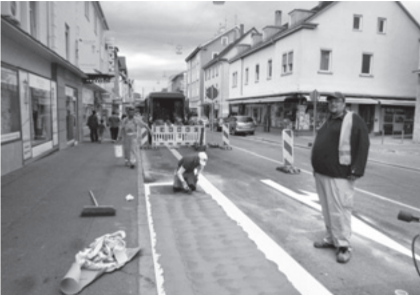
Die im vergangenen Jahr markierte Aufstellfläche für Radfahrer in der Schillerstraße hat sich in der Praxis bestens bewährt
